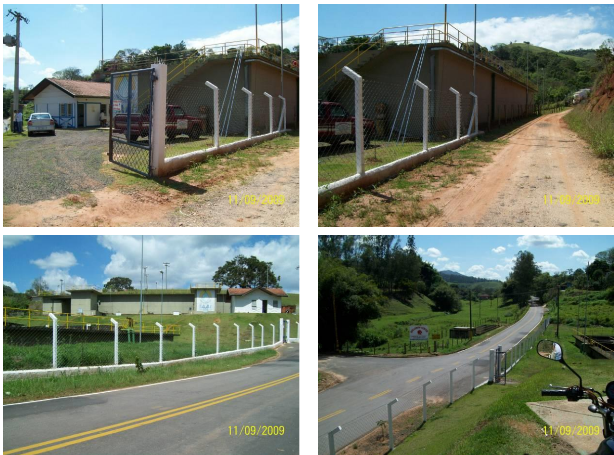
Figura 9.2-A: Vistas gerais da ETE do Barreiro. Em cima – corpo principal da estação; em baixo à esq. – corpo principal ao fundo, vendo-se partedo leito de secagem de lodo à frente; em baixo à esq. – módulo de tratamento primário do outro lado da estrada.
