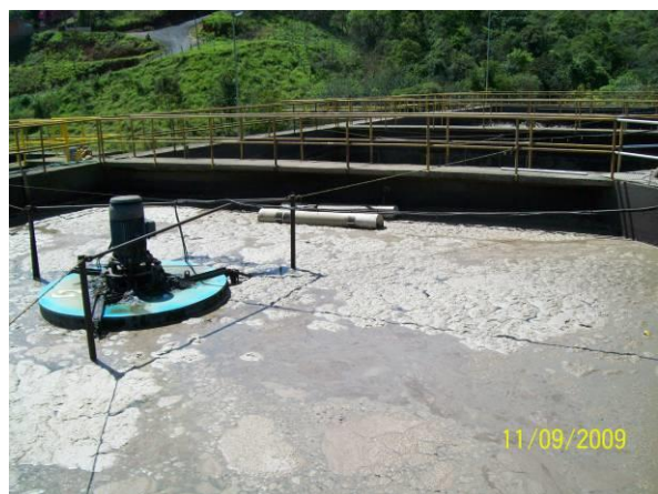
Figura 9.2-C: À esq. – o primeiro dos quatro reatores, no qual se observa a flotação de espuma; à dir – tanque adensador de lodo
