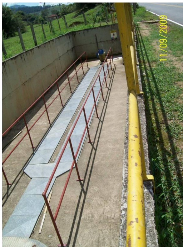
Figura 9.2-B: Vistas do módulo de tratamento primário. À esq. – gradeamento, caixa de desarenação e poço de recalque; à dir. – caixa de desarenação.
