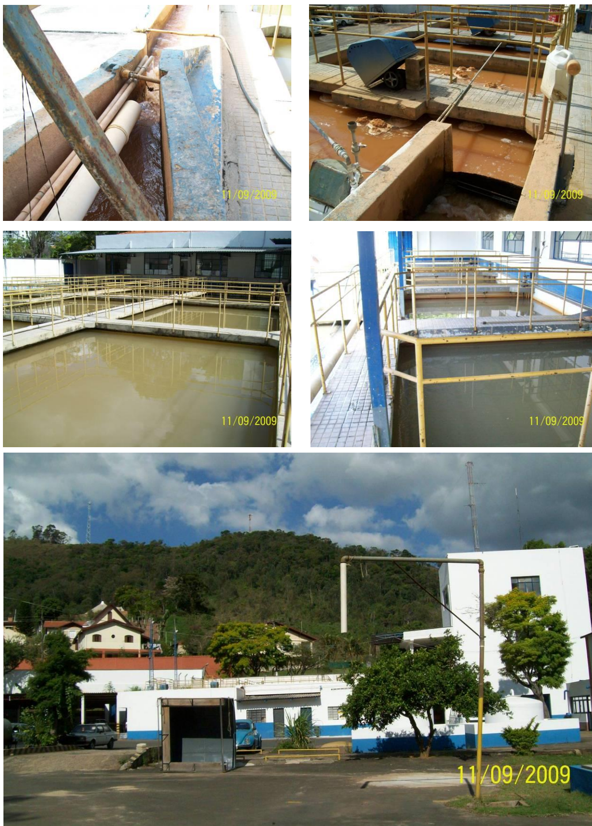
Figura 8.3-C: A partir do canto sup. esq., no sentido horário – calha Parshall com medidor ultrassônico; floculadores; filtros; vista externa da ETA; decantadores
