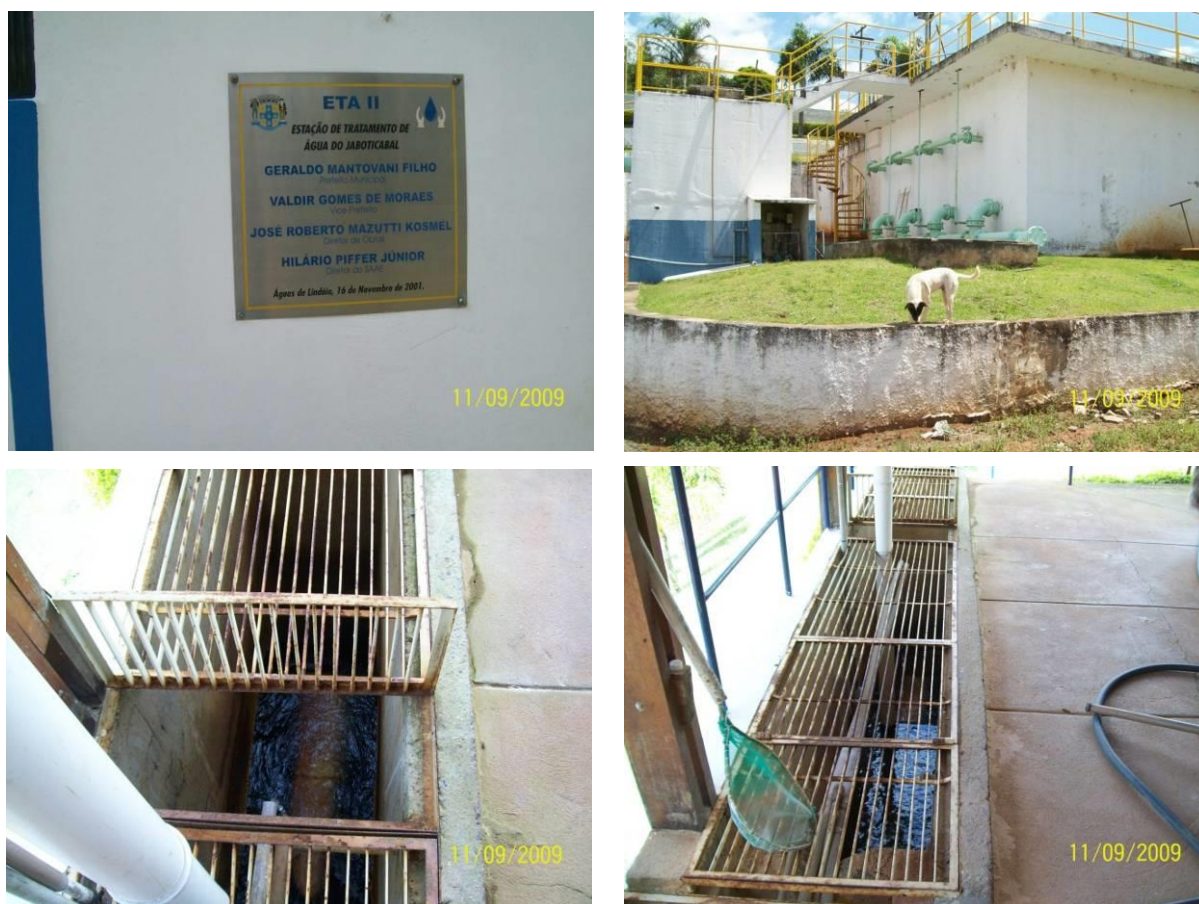
Figura 8.3-I: A partir do canto sup. esq., no sentido horário – placa comemorativa da inauguração; vista parcial externa; entrada da água bruta; mistura rápida
