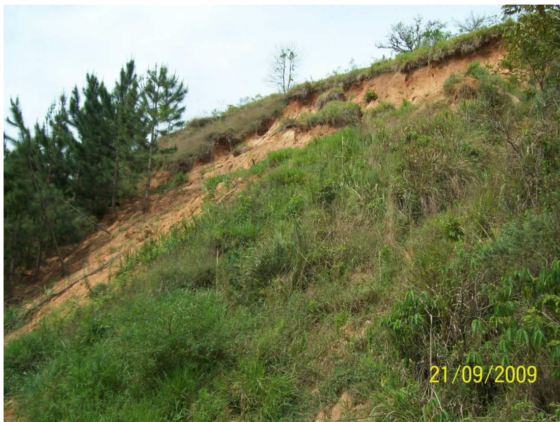
Figura 8.1-B: Erosão e escorregamento em encosta do Morro do Mirante no bairro do Cavalinho Branco
