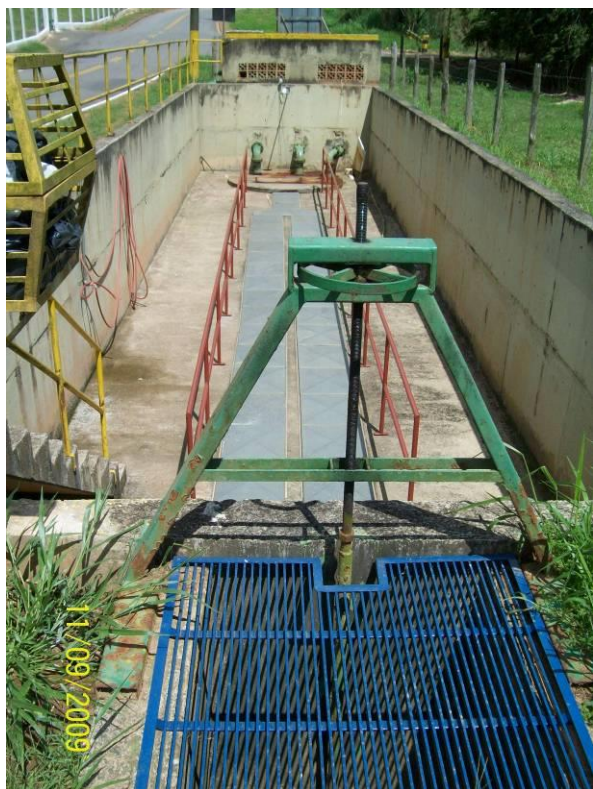
Figura 9.2-B: Vistas do módulo de tratamento primário. À esq. – gradeamento, caixa de desarenação e poço de recalque; à dir. – caixa de desarenação.
