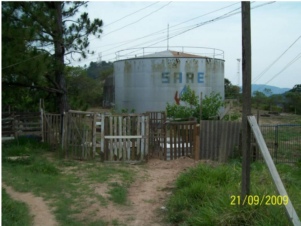
Figura 8.5-B: Centros de reservação Mirante e Reservatório Central
