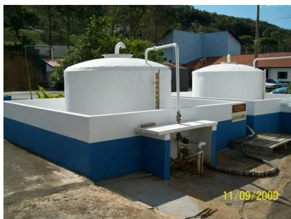
Figura 8.3-F: Em cima – dosagem de sulfato; em baixo - tanques de sulfato de alumínio, notando-se a existência de bacias de contenção
