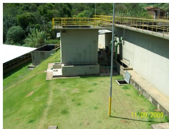
Figura 9.2-C: À esq. – o primeiro dos quatro reatores, no qual se observa a flotação de espuma; à dir – tanque adensador de lodo
