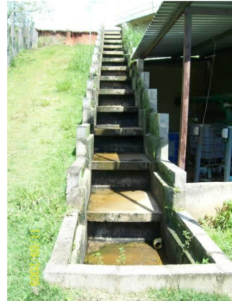
Figura 9.2-D: Em cima à esq. –tanque adensador de lodo à frente e tanque de contato ao fundo; em cima à dir. – tanque de contato, observando-se a falta de chicanas; em baixo à esq. – dosadores de cloro; em baixo à dir. – escada de aeração implantada em função do superdimensionamento da ETE na fase inicial, a fim de elevar a OD de 4 para 5,0 / 5,5
